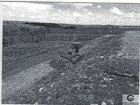
Manutenção na estrada de acesso. — Aterro Sanitário de Ituiutaba-MG.
