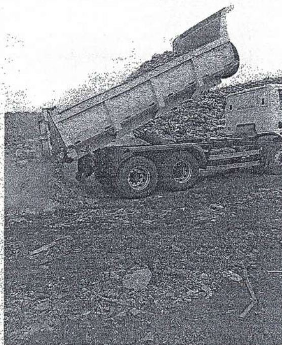
Manutenção vias de acesso RSU. – Aterro Sanitário de Ituiutaba-MG.
