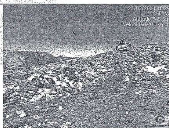
Realização da compactação do lixo domiciliar. – Aterro Sanitário de Ituiutaba-MG.
