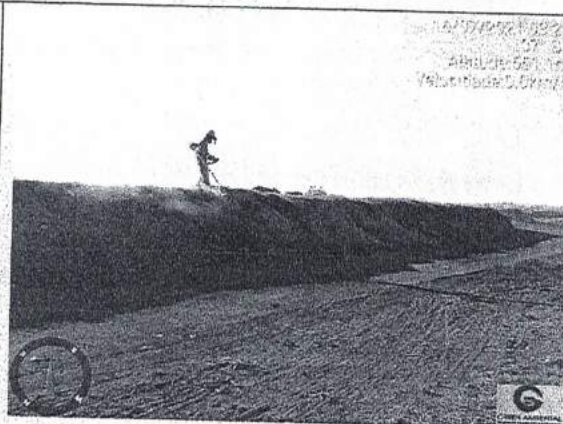
Raçagem. – Aterro Sanitário de Ituiutaba-MG.
