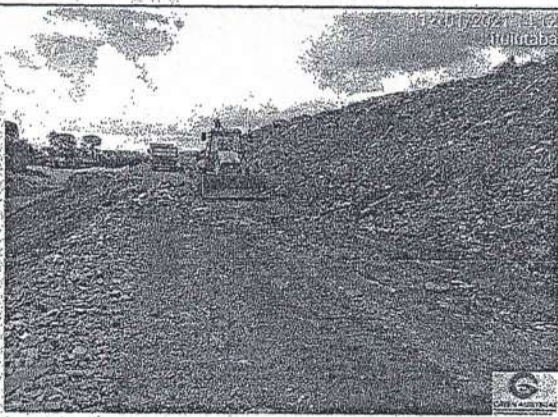
Manutenção vias de acesso RSU. – Aterro Sanitário de Ituiutaba-MG.
