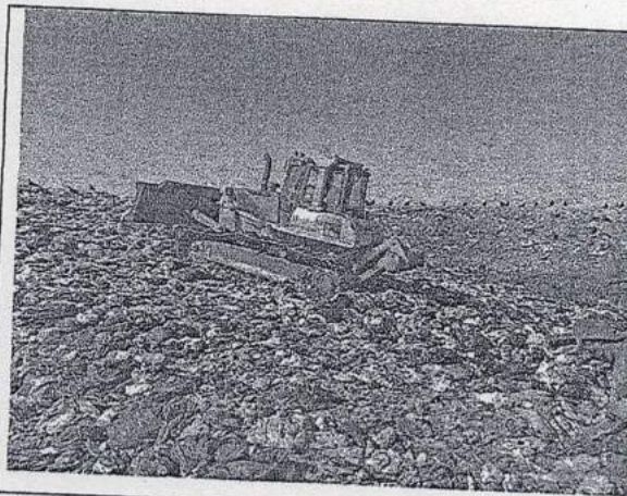
Compactação do lixo. — Aterro Sanitário de Ituiutaba-MG.
