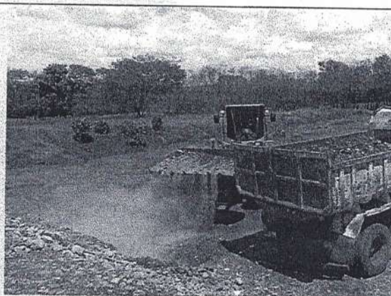
Trituração. — Aterro Sanitário de Ituiutaba-MG.
