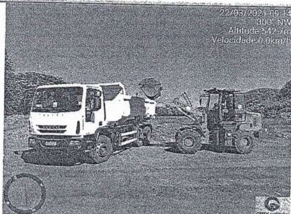
Carregamento de RCC. – Aterro Sanitário de Ituiutaba-MG.
