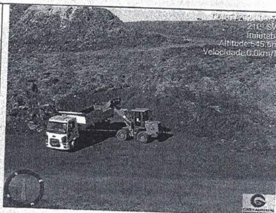
Realizando a retirada da terra para realizar a cobertura da lateral do lixo. — Aterro Sanitário de Ituiutaba-MG.
