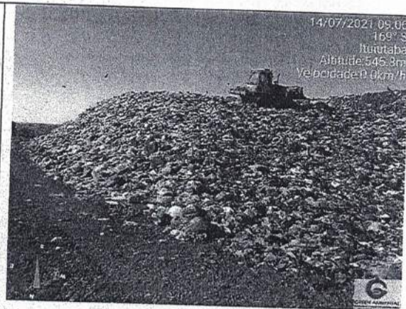
Realização da compactação do lixo. – Aterro Sanitário de Ituiutaba-MG.
