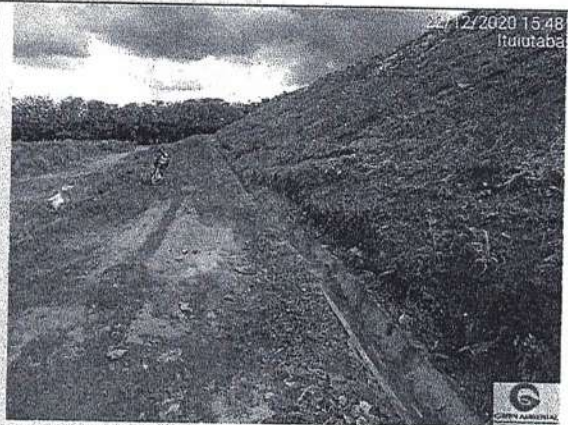
Canaletas. — Aterro Sanitário de Ituiutaba-MG.
