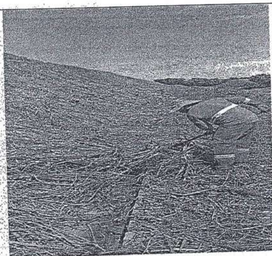
Manutenção e Limpeza das canaletas. — Aterro Sanitário de Ituiutaba-MG.
