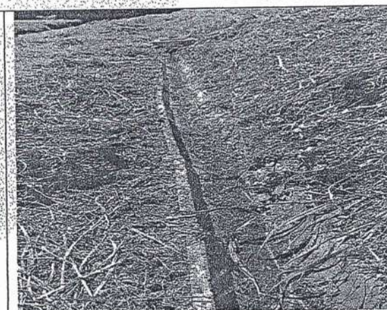
Canaletas Desobstruídas. — Aterro Sanitário de Ituiutaba-MG.
