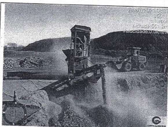
Material sendo triturado. – Aterro Sanitário de Ituiutaba-MG.
