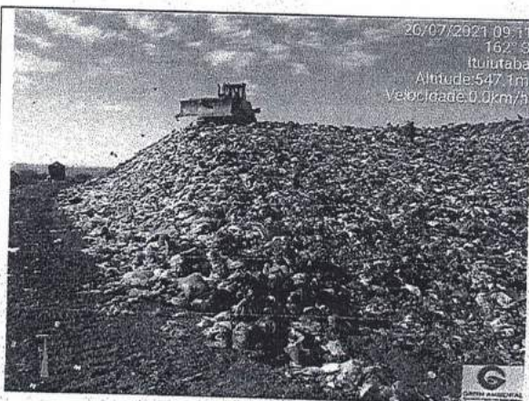
Compactação do lixo. – Aterro Sanitário de Ituiutaba-MG.
