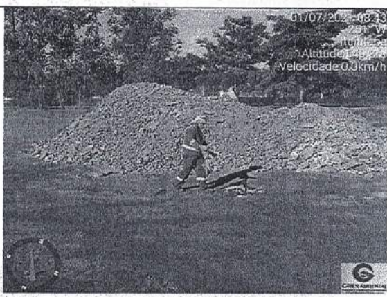
Entulho para ser triturado. – Aterro Sanitário de Ituiutaba-MG.
