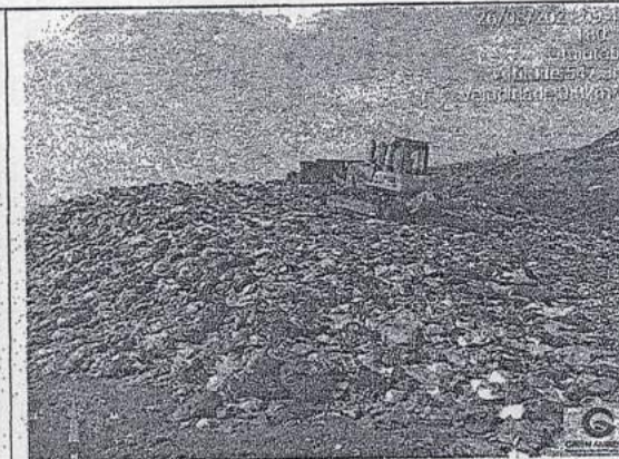
Compactação do lixo. – Aterro Sanitário de Ituiutaba-MG.
