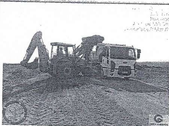
Transporte de terra para cobertura do lixo. — Aterro Sanitário de Ituiutaba-MG.
