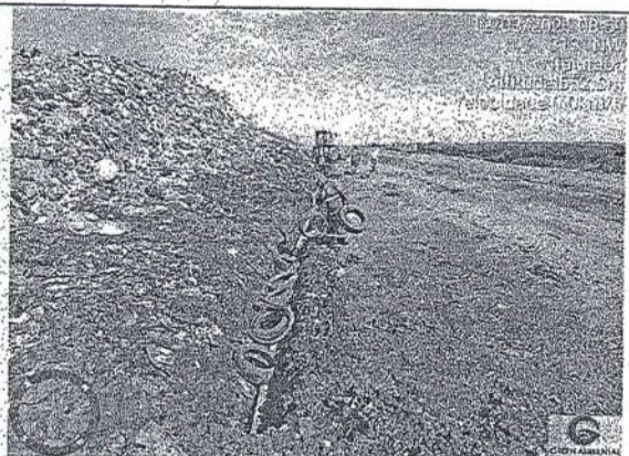
Colocação de pneus em toda drenagem. — Aterro Sanitário de Ituiutaba-MG.
