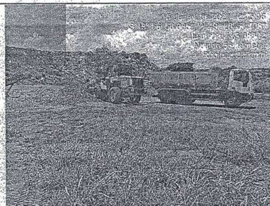
Retirada do RCC pela Prefeitura. — Aterro Sanitário de Ituiutaba-MG.
