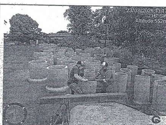
Carregamento das manilhas para drenagem vertical. – Aterro Sanitário de Ituiutaba-MG.
