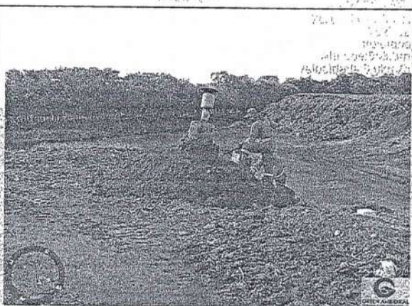
Realizou adição de terra no pé do BIOGAS. – Aterro Sanitário de Ituiutaba-MG.
