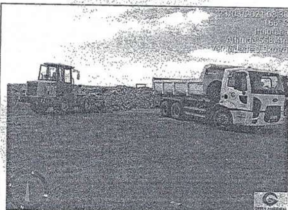
Carregamento de entulho trilhado para ser processado. – Aterro Sanitário de Ituiutaba-MG.
