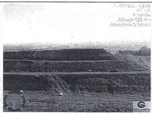
Cobertura com terra na lateral da célula de lixo. – Aterro Sanitário de Ituiutaba-MG.
