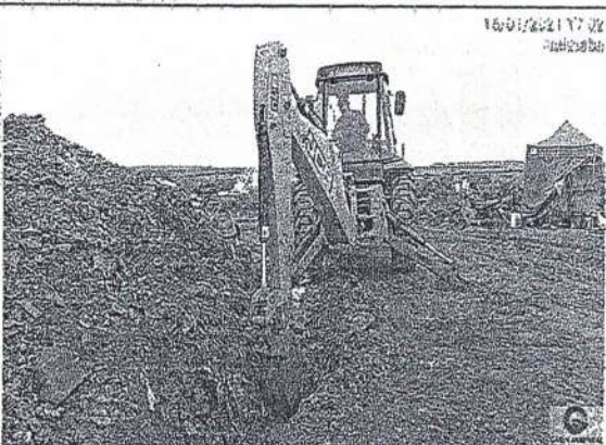
Manutenção de pé de talude. – Aterro Sanitário de Ituiutaba-MG.
