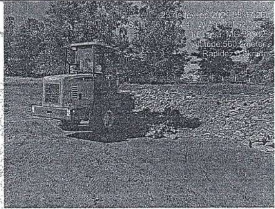
Estoque do entulho para britagem. — Aterro Sanitário de Ituiutaba-MG.
