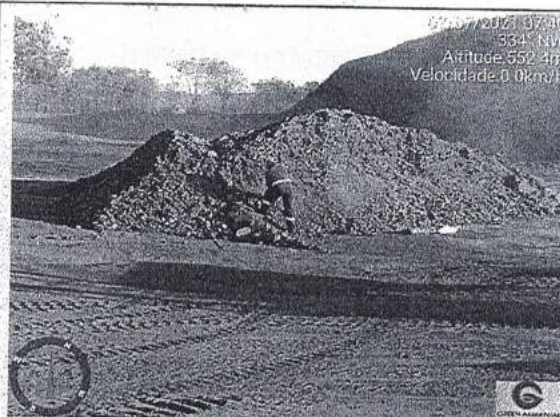
Entulho separado para realizar a trituração. — Aterro Sanitário de Ituiutaba-MG.
