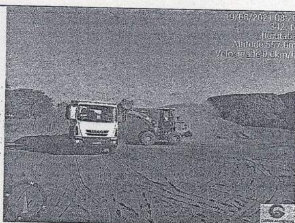
Prefeitura buscando RCC para as estradas. – Aterro Sanitário de Ituiutaba-MG.
