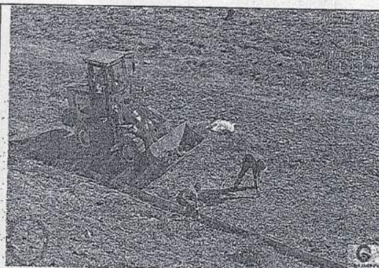
Limpeza das canaletas. — Aterro Sanitário de Ituiutaba-MG.
