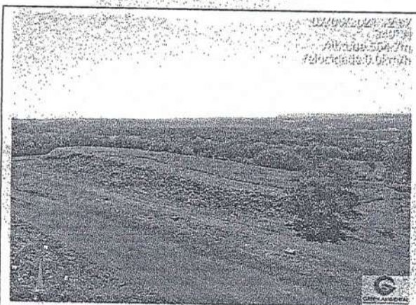
Rocagem na célula de lixo desativada. — Aterro Sanitário de Ituiutaba-MG.
