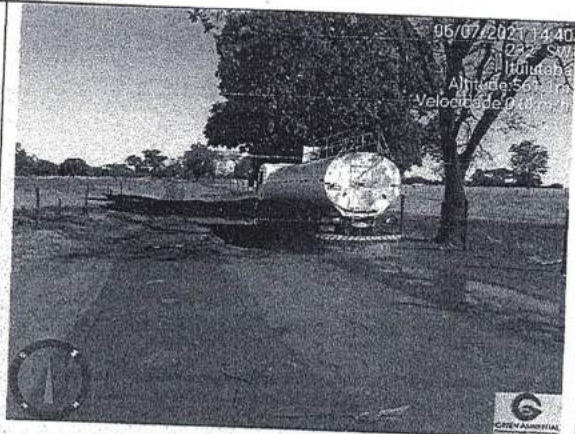
Realizando a umectação das vias da entrada do aterro. – Aterro Sanitário de Ituiutaba-MG.
