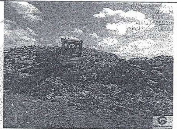
Compactação do lixo domiciliar. – Aterro Sanitário de Ituiutaba-MG.
