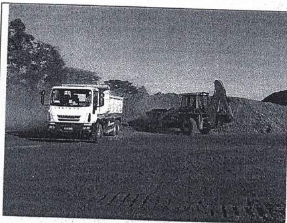
Transporte de entulho triturado para vias rurais. – Aterro Sanitário de Ituiutaba-MG.
