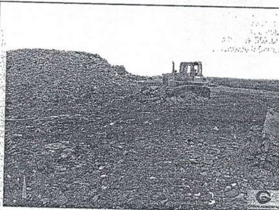
Material lançado para calçar plataforma. — Aterro Sanitário de Ituiutaba-MG.
