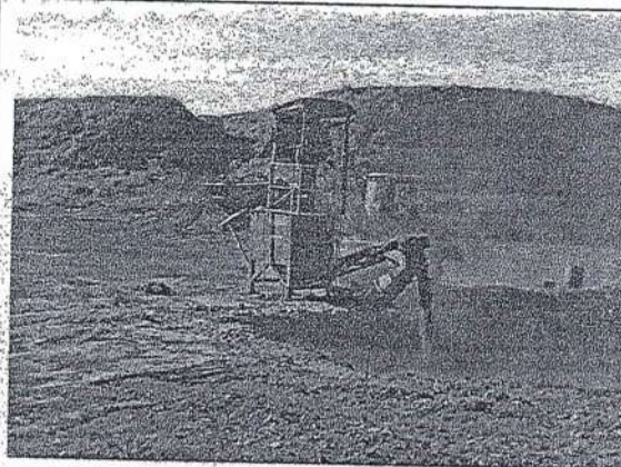
Material sendo triturado. — Aterro Sanitário de Ituiutaba-MG.
