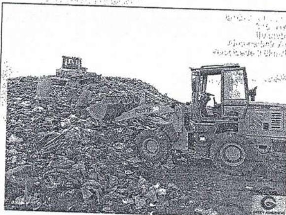
Levantamento de dreno vertical. — Aterro Sanitário de Ituiutaba.
