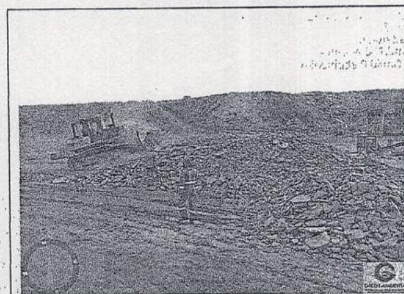
Estoque do entulho triado. – Aterro Sanitário de Ituiutaba-MG.
