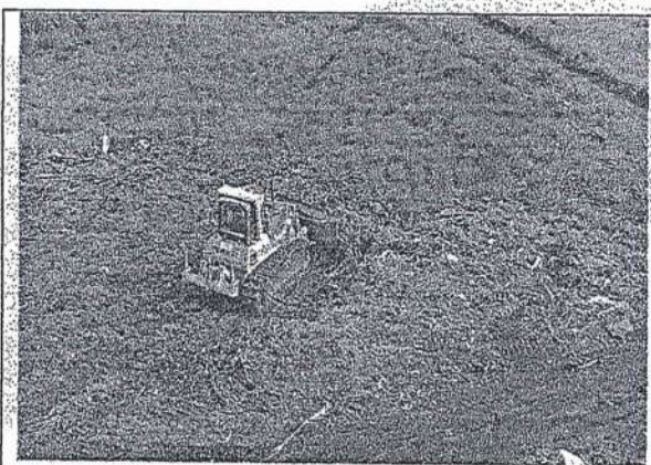
Manutenção na célula de poda. – Aterro Sanitário de Ituiutaba-MG.
