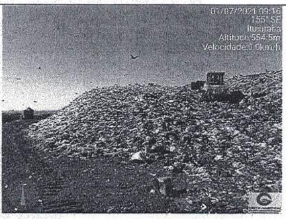
Compactação de lixo. – Aterro Sanitário de Ituiutaba-MG.
