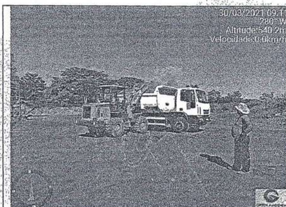
Retirada RCC para estradas municipais. – Aterro Sanitário de Ituiutaba-MG.
