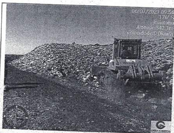
Compactação. — Aterro Sanitário de Ituiutaba-MG.
