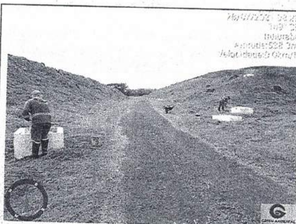
Realização da pintura das caixinhas. – Aterro Sanitário de Ituiutaba-MG.
