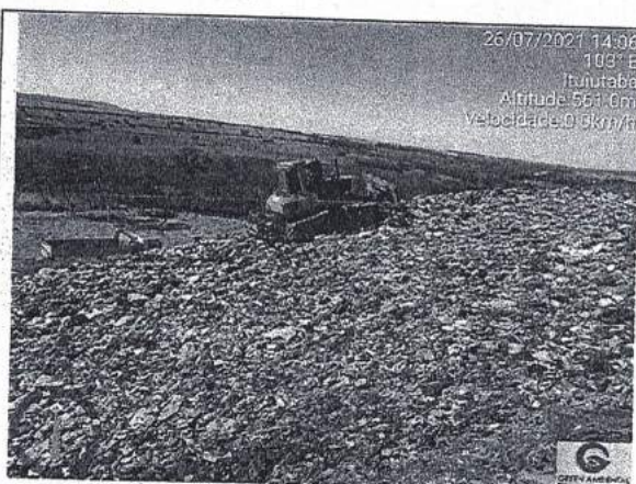
Compactação do lixo. – Aterro Sanitário de Ituiutaba-MG.
