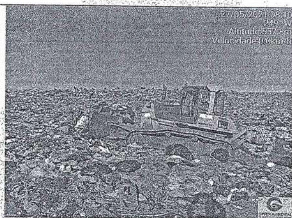
Compactação. – Aterro Sanitário de Ituiutaba-MG.
