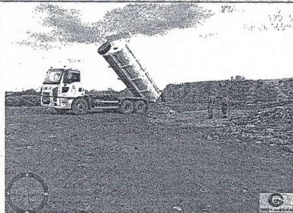
Realizando o calçamento para descarregamento do lixo noturno. – Aterro Sanitário de Ituiutaba-MG.
