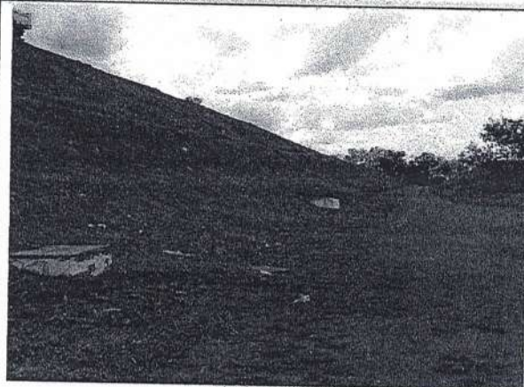
Taludes. — Aterro Sanitário de Ituiutaba-MG.
