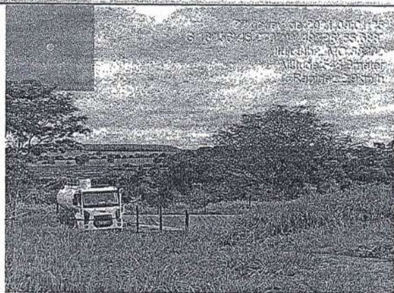
Retirada do Chorume para ERPAL. — Aterro Sanitário de Ituiutaba-MG.
