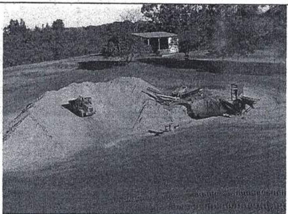
Material que foi triturado. – Aterro Sanitário de Ituiutaba-MG.
