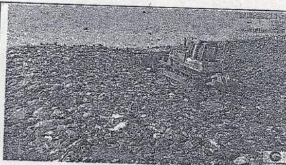
Compactação do lixo. – Aterro Sanitário de Ituiutaba-MG.
