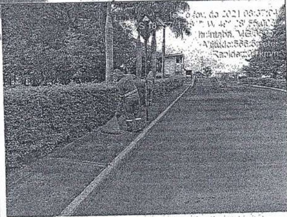
Manutenção das vias de acesso. — Aterro Sanitário de Ituiutaba-MG.
