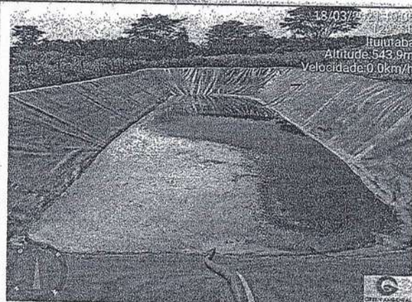
Lagoa de chorume com seu nível baixo. — Aterro Sanitário de Ituiutaba-MG.
