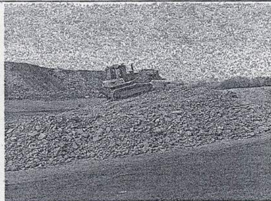
Compactação do entulho triado para realizar a trituração. – Aterro Sanitário de Ituiutaba-MG.
