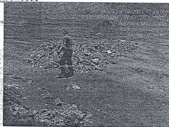
Separação de materiais para realização da britagem. — Aterro Sanitário de Ituiutaba-MG.
