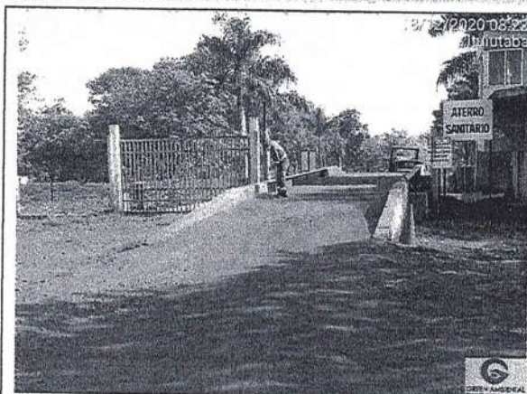
Limpeza na entrada do aterro. – Aterro Sanitário de Ituiutaba-MG.
