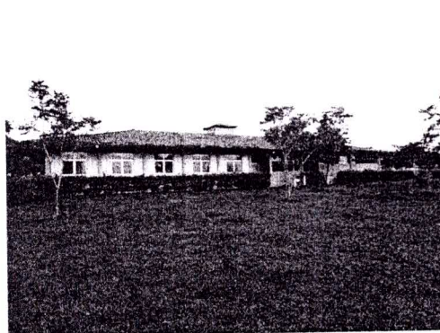
Foto 03: Unidade de apoio. Escritório, Sala de reunião Sala de Educação Ambiental, refeitório e vestiários
