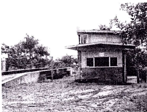
Foto 01: Entrada do aterro – guarita e balança
