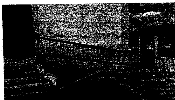
Figura 08: Detalhe de corrimãos e guarda corpos. À direita, rampa de acessibilidade não atende à Norma ABNT NBR 9050.
