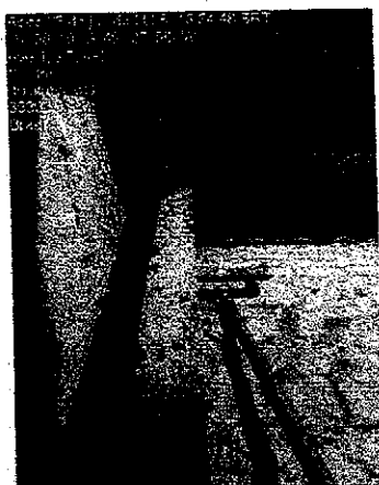
Figura 36: Detalhe do pilar com muitas brocas no concreto. À direita, observa-se a trinca na parede que, aparentemente, estende-se pelas paredes da Sacristia, Capela de Nossa Senhora das Graças e Presbitério.
