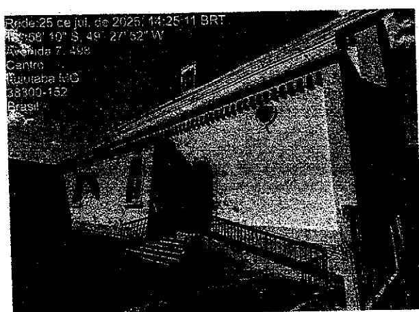
Figura 03: Fachada Oeste – vários pontos de degradação do reboco e pintura.
