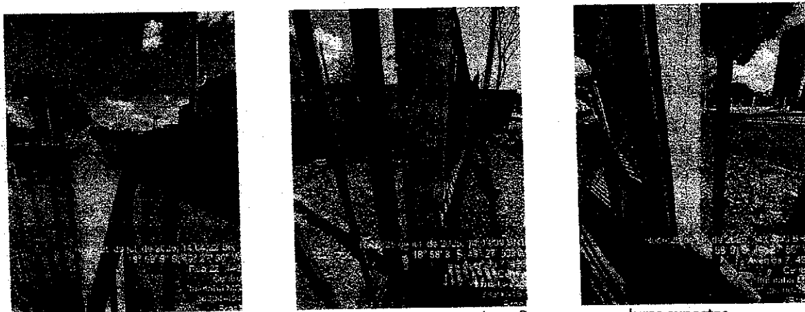
Figura 47: Detalhes da situação dos pilares das muretas e grades – fissuras e armaduras expostas.
