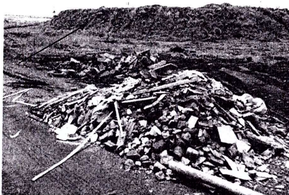
Foto 17: Pilha de armazenagem de resíduos da construção civil
