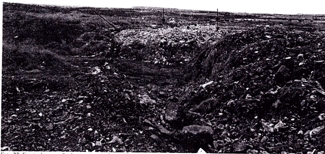
Foto 22: Frente de operação de aterramento dos resíduos domésticos
