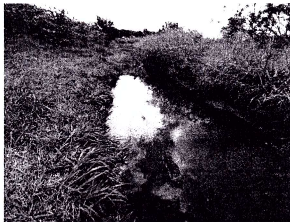
Foto 26: poça de chorume em outra estrada interna do aterro
